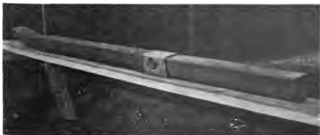
Abb. 106 c. Unterlafettenrohr mit aufgeschumpfter Muffe.
